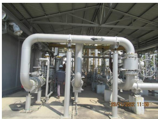
ภาพที่ 2-36 วาล์วควบคุมการจ่ายก๊าซ
