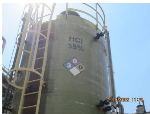
ภาพที่ 2-28 ถังเก็บสารละลาย HCl
