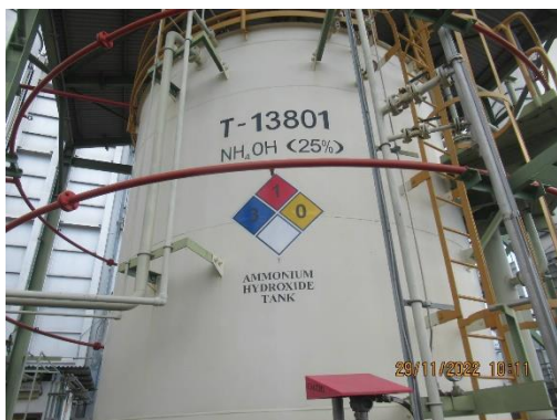
ภาพที่ 2-30 ถังเก็บสารละลาย \text{NH}_4\text{OH}
