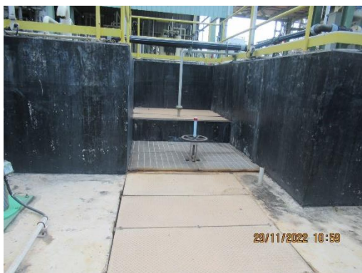
ภาพที่ 2-6 ป่อตรวจสอบคุณภาพน้ำทิ้ง (Inspection Manhole)
