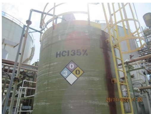
ภาพที่ 2-28 ถังเก็บสารละลาย HCl
