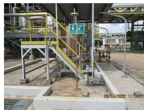
ภาพที่ 2-25 อ่างล้างตาและฝักบัวฉุกเฉิน
