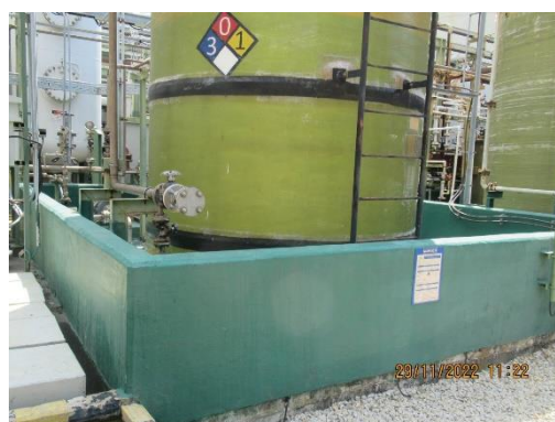
ภาพที่ 2-27 ถังเก็บสารละลาย NaOH
