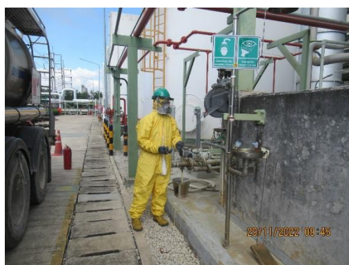
ภาพที่ 2-25 อ่างล้างตาและฝักบัวฉุกเฉิน
