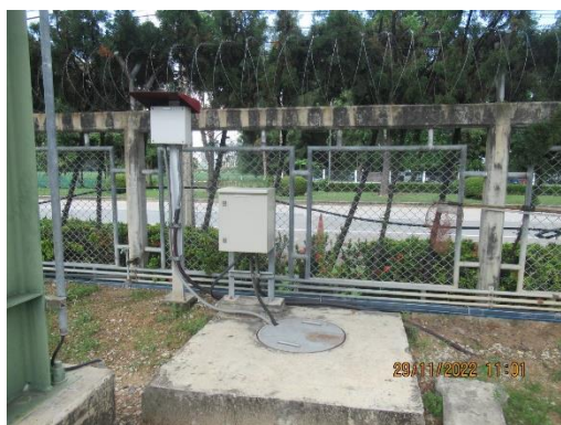
ภาพที่ 2-6 ป่อตรวจสอบคุณภาพน้ำทิ้ง (Inspection Manhole)
