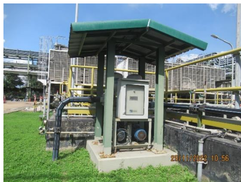
ภาพที่ 2-3 การติดตั้งอุปกรณ์เพื่อนำน้ำทิ้งกลับมาใช้ประโยชน์
