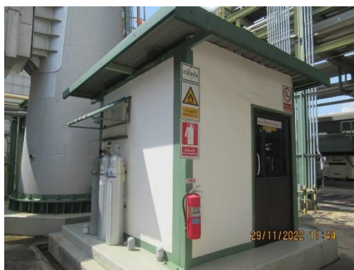
ภาพที่ 2-1 เครื่องตรวจวัดคุณภาพอากาศ (CEMs) ของโครงการ
