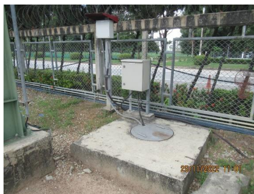
ภาพที่ 2-6 ป่อตรวจสอบคุณภาพน้ำทิ้ง (Inspection Manhole)
